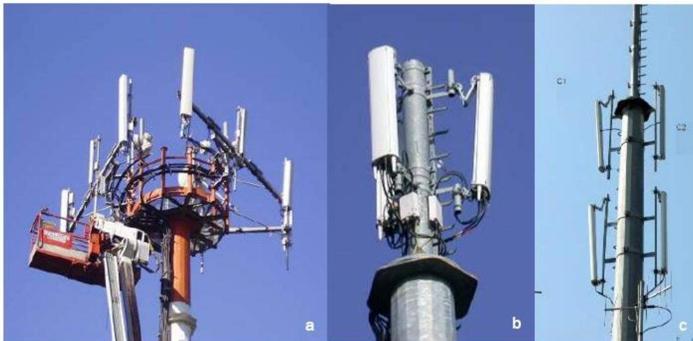
**a:** 2 antenne di ricezione + 1 antenna trasmissione, per settore.
